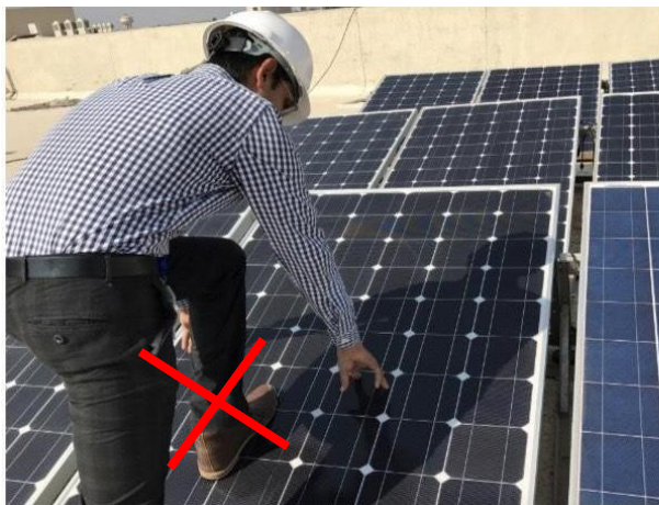
Hình 5. Không dẫm đạp hay đi lên các tấm pin
