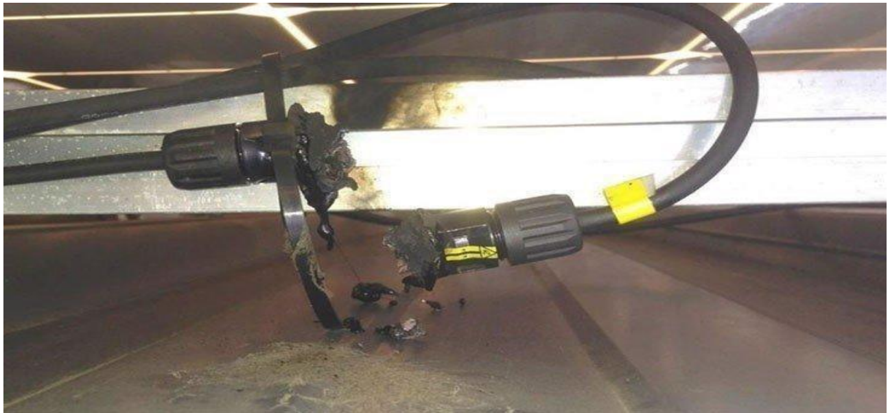
Hình 10 . Tiếp xúc kém dẫn đến cháy jack MC4
