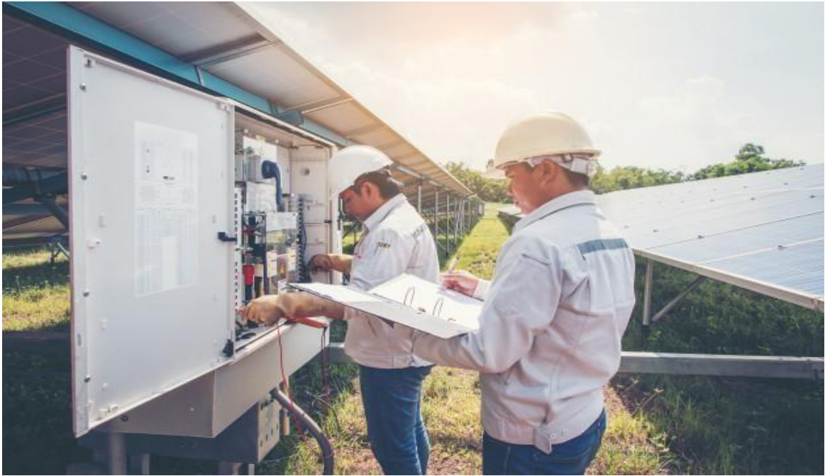
Hình 11. Kiểm tra tủ điện hệ thống
