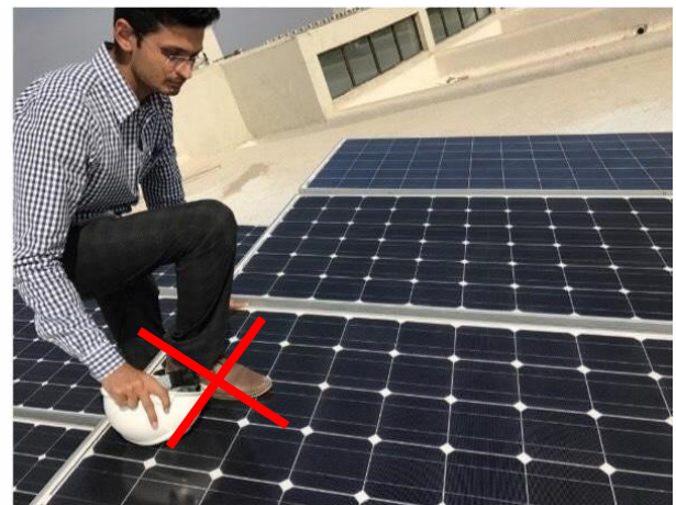
Hình 5. Không dẫm đạp hay đi lên các tấm pin
